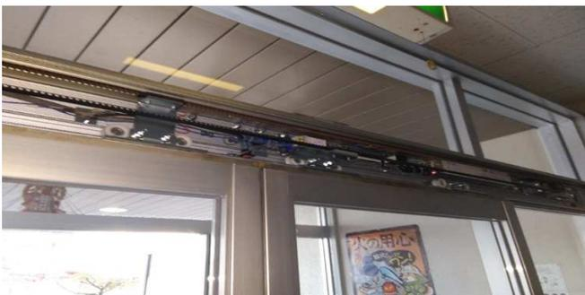
自動ドア開閉装置、内外無目付けセンサ、挟まれ防止用の補助光線センサを新しくしました。
