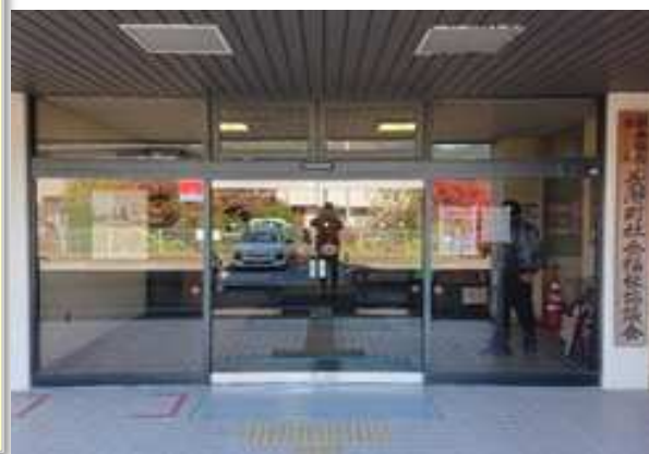
⑥新規自動ドア装置取付
