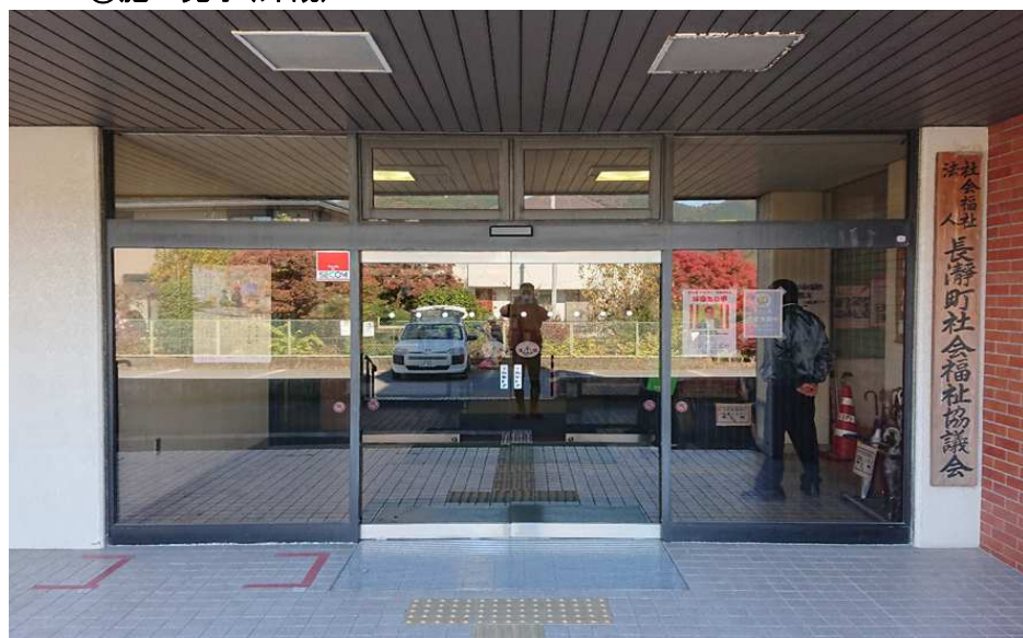
⑨施工完了(外観)
