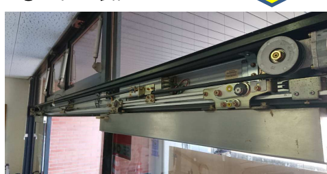
④自動ドア装置撤去
