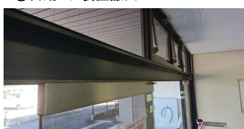
④自動ドア装置撤去
