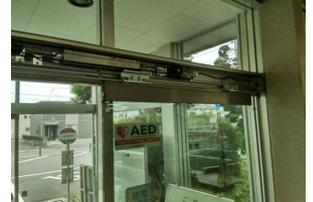
⑧内外起動センサを無目付けセンサに変更/補助光線センサを交換
