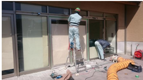
④ 自動ドア工事中
