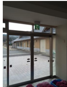
⑥ 設置完了(内観)
