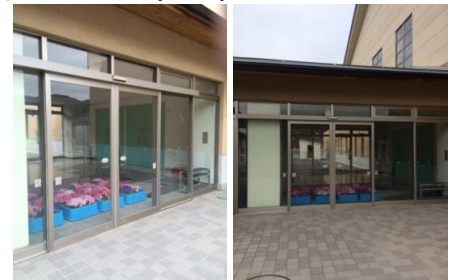
⑦ 設置完了(外観)
