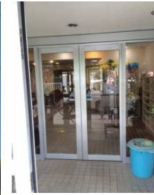
兵庫県川西市小戸2-13-12 老人憩いの家 鶴寿会館 様
