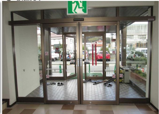
開き戸を撤去して、直付両引型の自動ドア装置を取り付けました。
