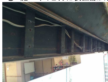
⑥ 施工中(新規装置)
