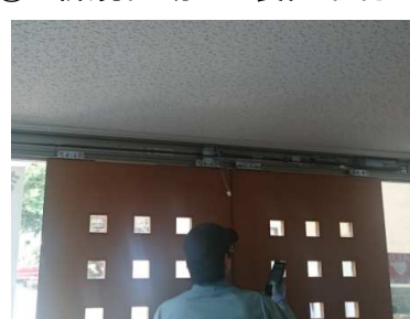
⑥ 自動ドア装置交換完了
