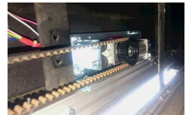
⑤ 施工中(駆動部)
