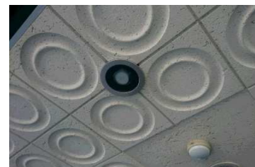
⑥ 施工中(旧センサ)
