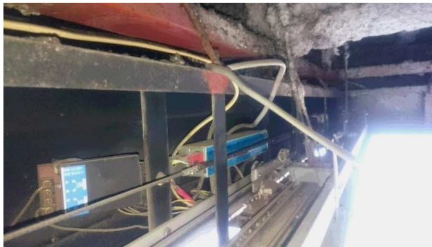
③ 施工中(老朽劣化自動ドア装置)
