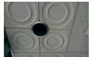
⑦ 施工中(新センサ)
