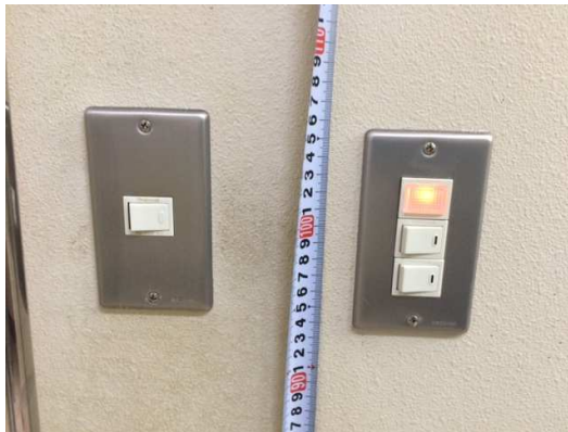
トイレ内電灯他スイッチの様子
