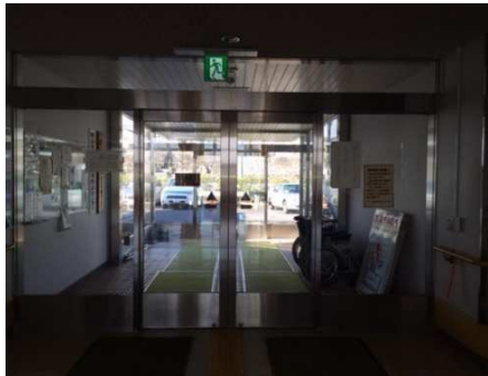
② 施工中(撤去前)
