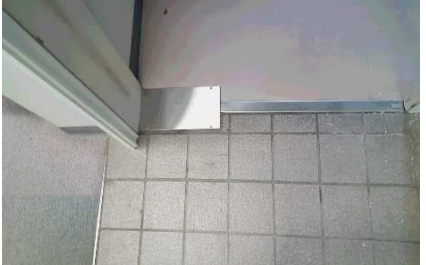
⑪ドア吊り込み調整
