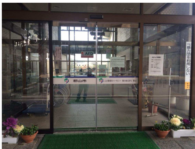
⑧ 自動ドア装置交換完了
