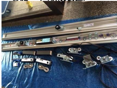
⑧ 自動ドア装置交換完了
