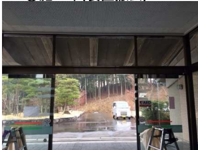
⑥施工中(新規装置)
