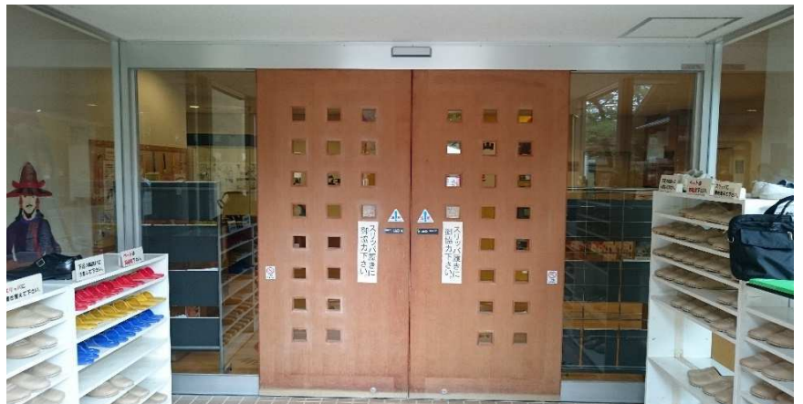
⑥ 自動ドア装置交換完了(外観写真)
