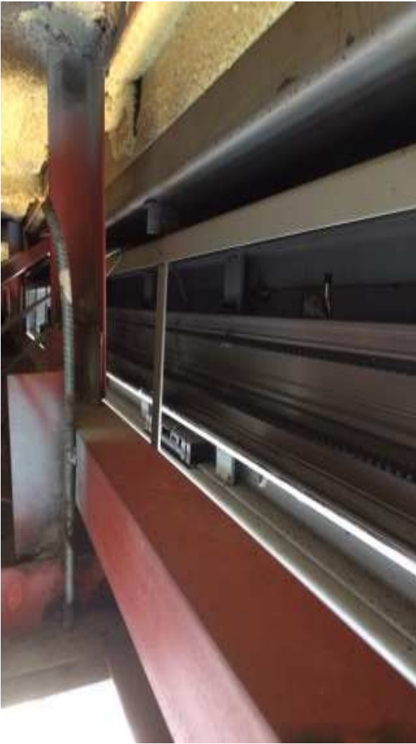
自動ドア開閉装置の様子
