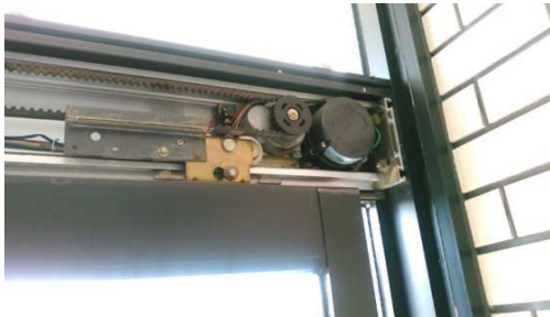
② 施工前(老朽劣化自動ドア装置)
