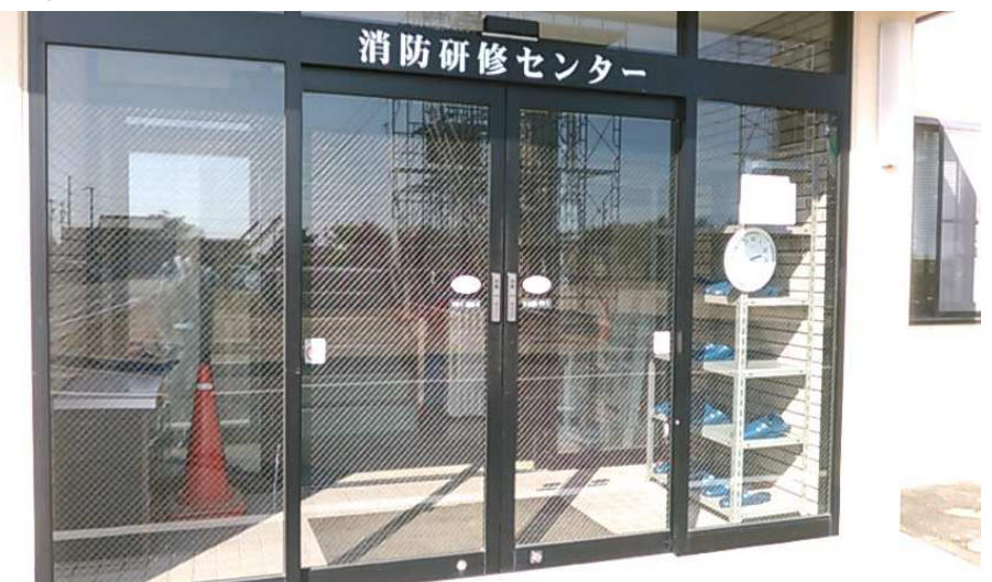
⑧ 施工完了
