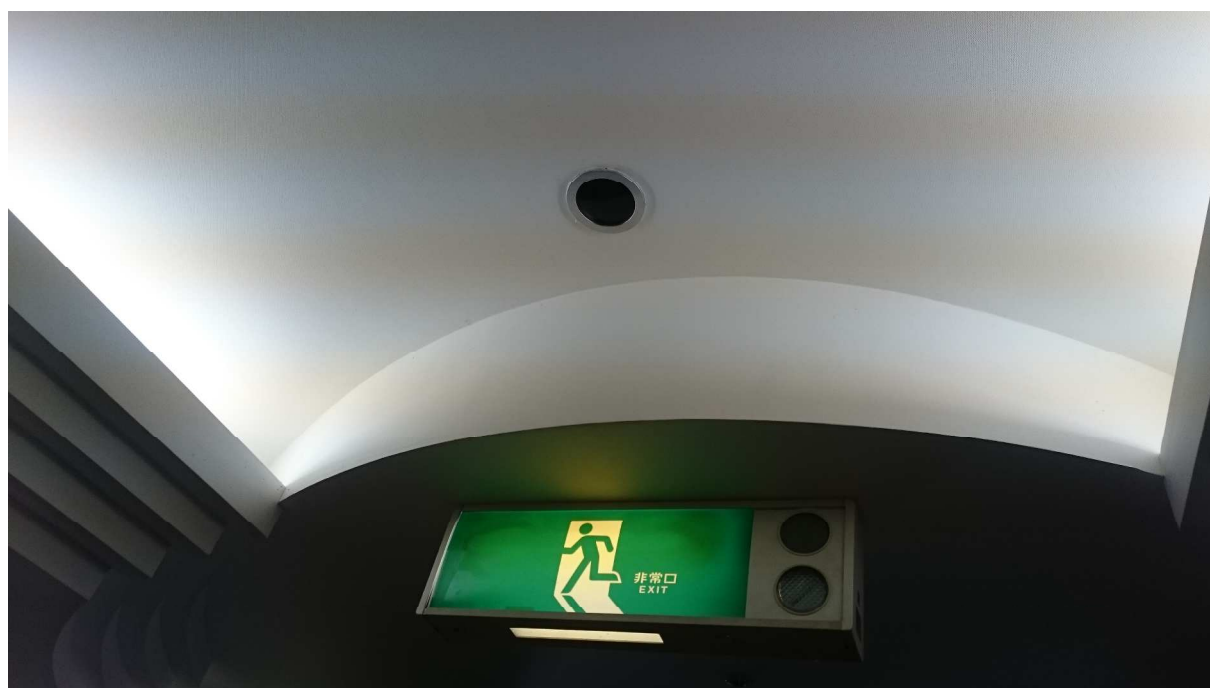
内側センサの様子（天井埋込センサ）
