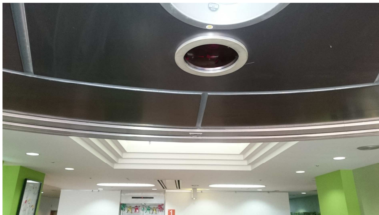
内側センサの様子（天井埋込センサ）
