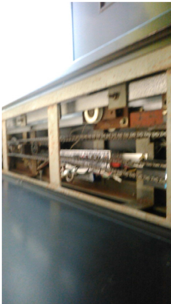
土壁のみち公衆トイレ 無目内部
