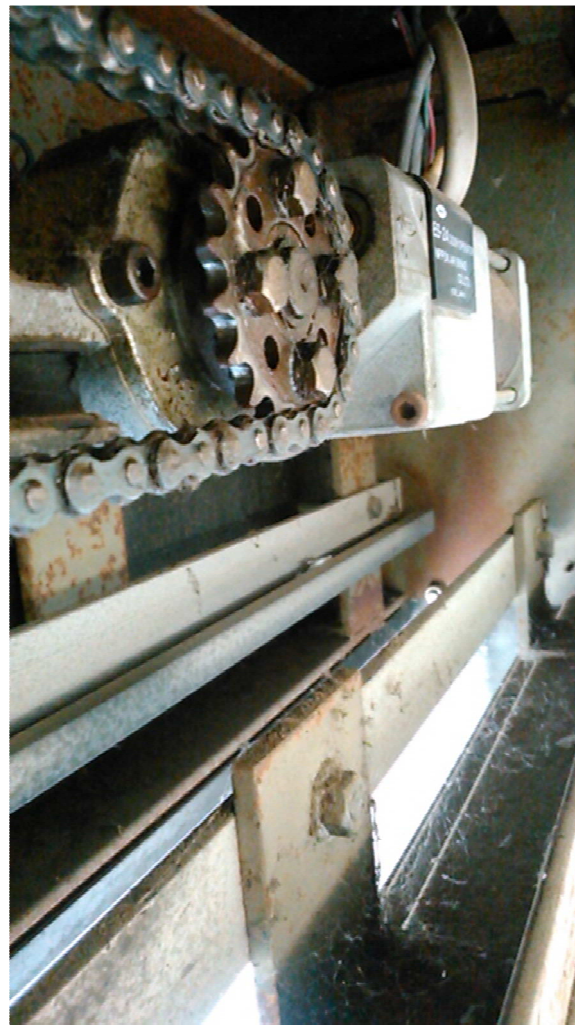
土壁のみち公衆トイレ 無目内部
