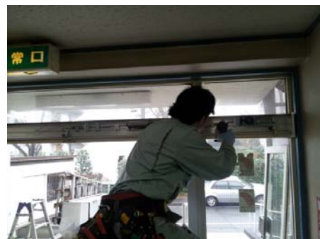
⑥ 施工中(自動ドア装置取付)
