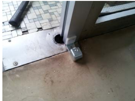
⑥ 施工中(自動ドア装置取付)
