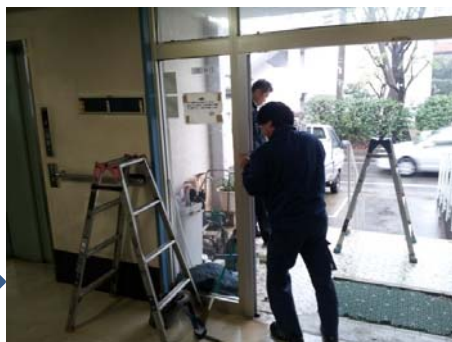
⑤ 施工中(ドアガイド取付)
