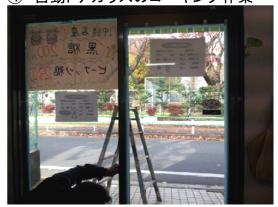
⑤ FIXガラスのコーキング作業 ガラスを止めていたビートや押し縁が外れて危険な状態でした シリコンコーキングによりガラスが固定されました。
