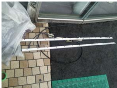
⑤ 新規自動ドア装置交換後 新規自動ドア装置内部
