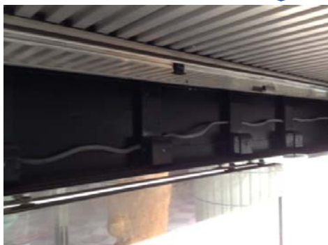
③ 老朽化部品撤去後
