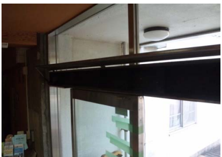
③ 老朽化自動ドア撤去中
