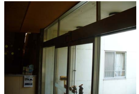
⑦ 新自動ドア装置取付後
