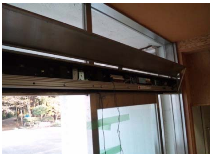
⑥ 新自動ドア装置取付中
