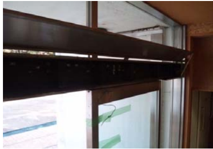
④ 老朽化自動ドア撤去
