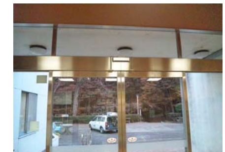
⑨ 新自動ドア装置取付後
