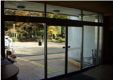
① 交換前の自動ドア装置
