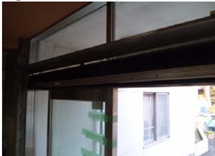
⑤ 新自動ドア装置取付中
