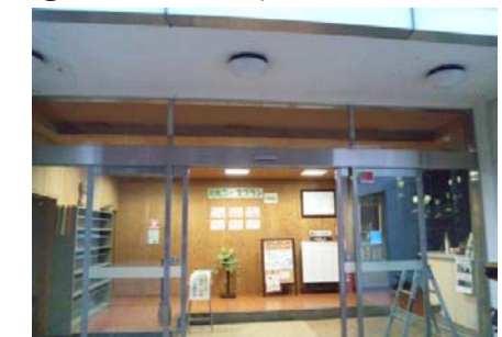
⑧ 新自動ドア装置取付後
