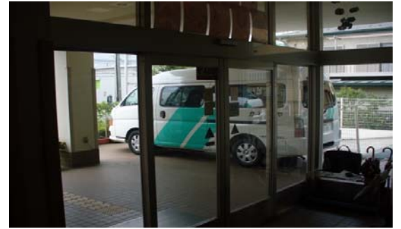
④ 新規自動ドア開閉装置取付
