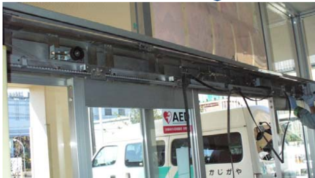
③ 老朽化部品撤去後
