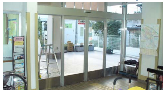
⑥ 新規自動ドア装置交換(外観)
