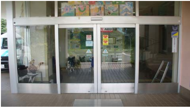
② 老朽化部品撤去中
