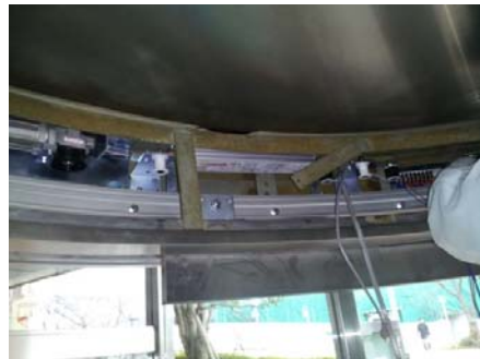
④ 新規自動ドア開閉装置
