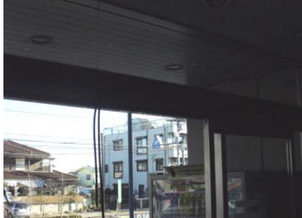
② 老朽化自動ドア撤去中
