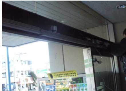
③ 新自動ドア装置取付中
