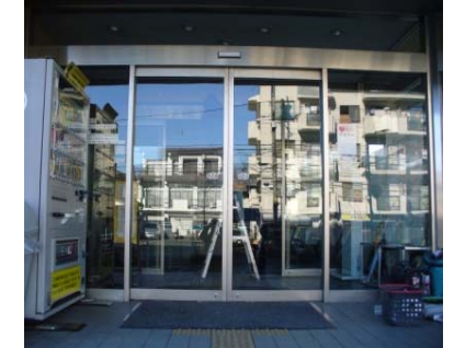
⑧ 新自動ドア装置取付後
