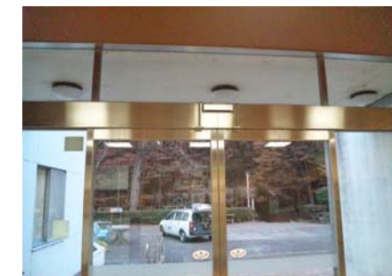
⑨ 新自動ドア装置取付後
