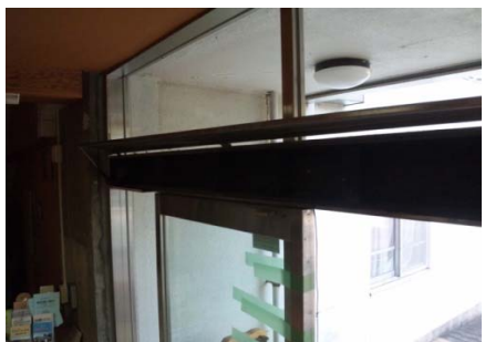
③ 老朽化自動ドア撤去中
