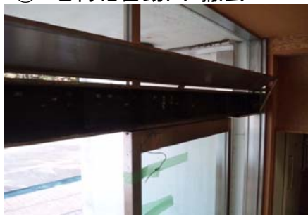
④ 老朽化自動ドア撤去
