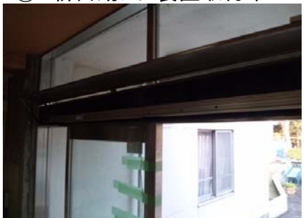
⑤ 新自動ドア装置取付中
