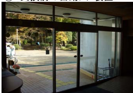
① 交換前の自動ドア装置
