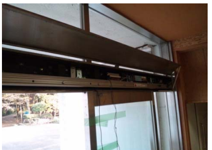
⑥ 新自動ドア装置取付中
