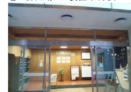
⑧ 新自動ドア装置取付後
