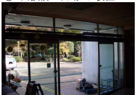
② 交換前の自動ドア装置
