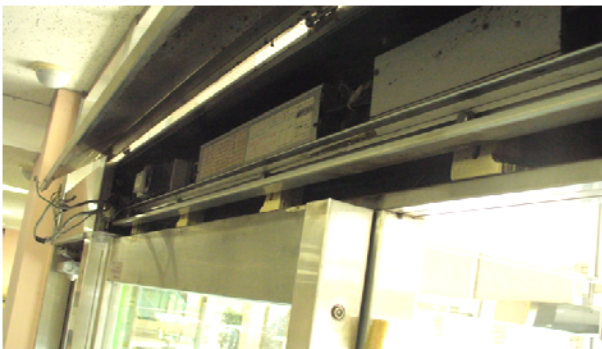
③ 撤去した自動ドア装置部品
