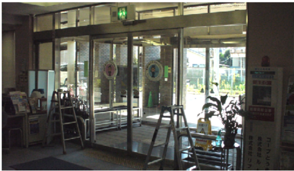
② 老朽化した自動ドア開閉装置
