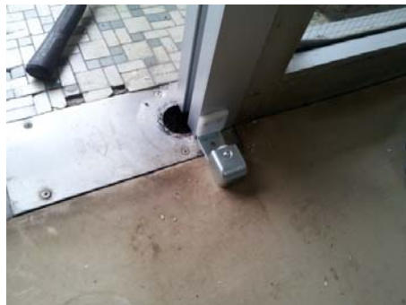
⑥ 施工中(自動ドア装置取付)
