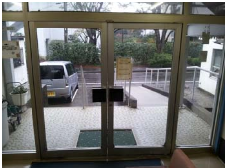
② 施工中(撤去前)
