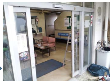
⑧ 施工中(コーキング作業中)
