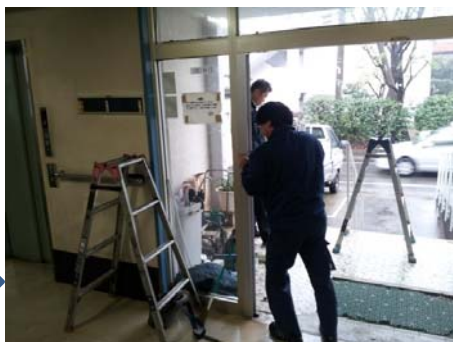
⑤ 施工中(ドアガイド取付)
