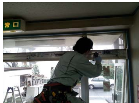
⑥ 施工中(自動ドア装置取付)
