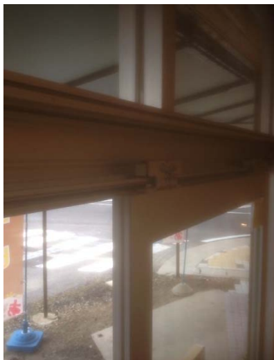
② 半自動ドア装置内部
