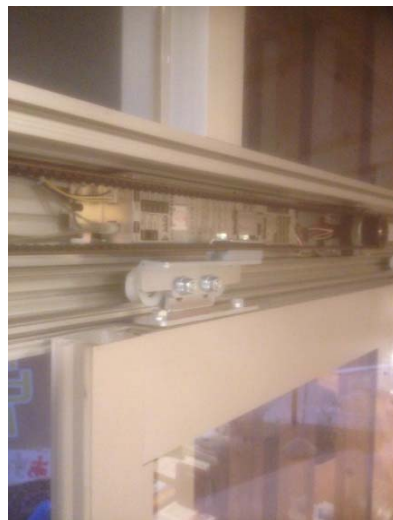
④ 自動ドア装置取付後
