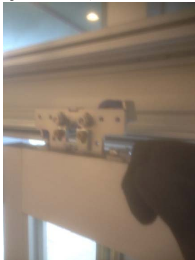
③ 半自動ドア装置撤去中
