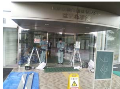
自動ドア装置取付作業中
