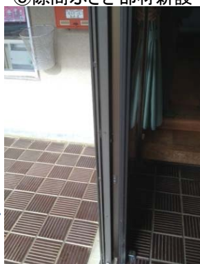
⑤隙間ふさぎ部材新設
