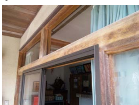
③施工前外観 詳細
