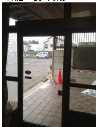
⑨施工後 内観
