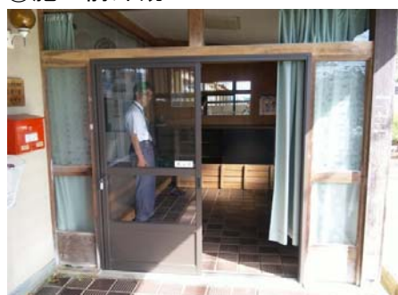
②施工前外観
