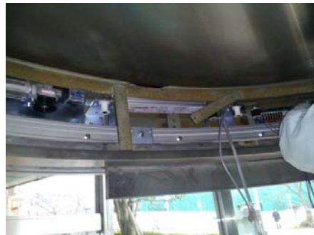
④ 新規自動ドア開閉装置
