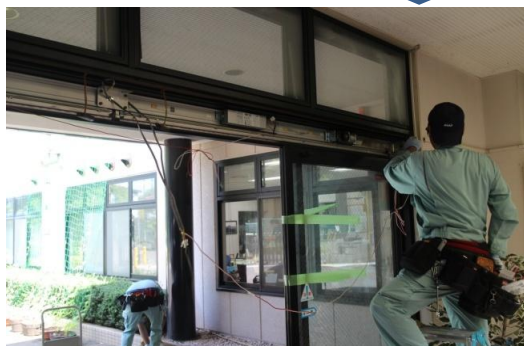
③ 老朽化部品撤去後
