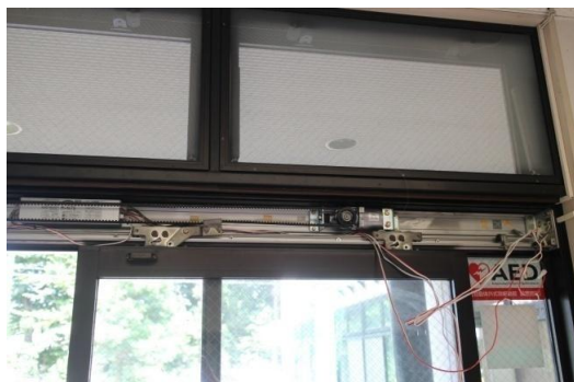
② 老朽化部品撤去中
