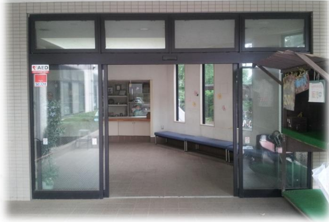
① 老朽化した自動ドア装置
