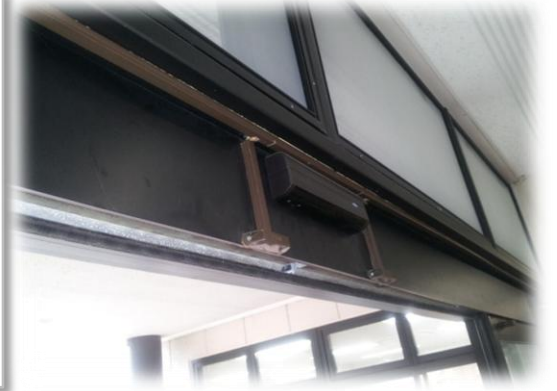
④ 新規自動ドア開閉装置取付
