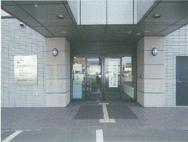
▲玄関（風除室及び自動ドアを増設する箇所）
