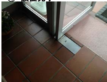
⑥ 設置完了
