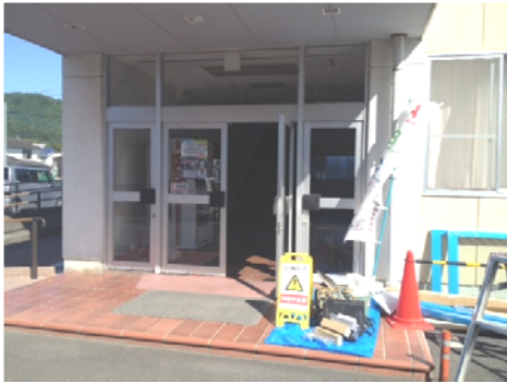
② 施工中(ドア取外し)
