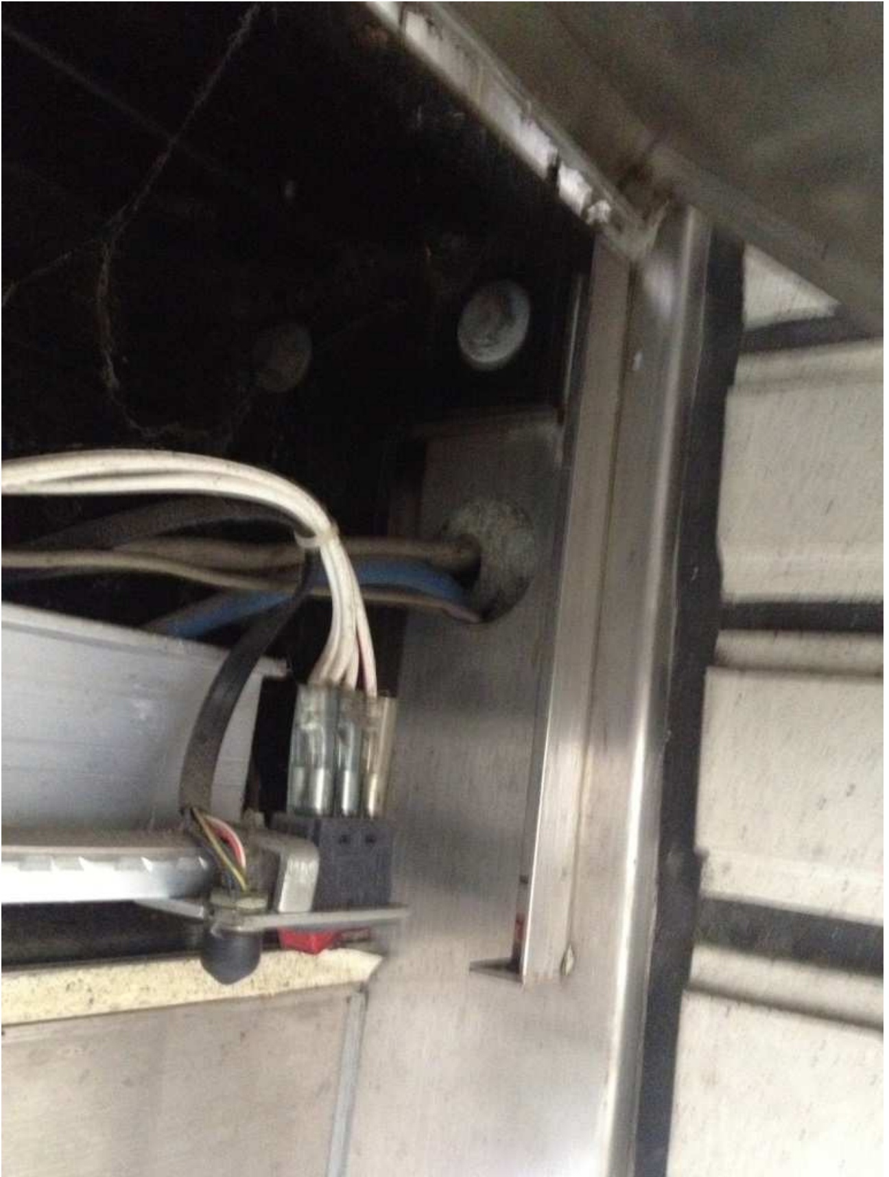
↓補助光線配線エンジンボックス内部の様子
