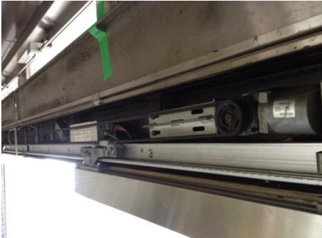
③ 施工中(自動ドア装置撤去)
