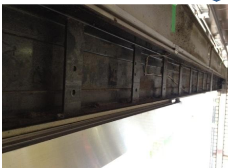
③ 施工中(自動ドア装置撤去)
