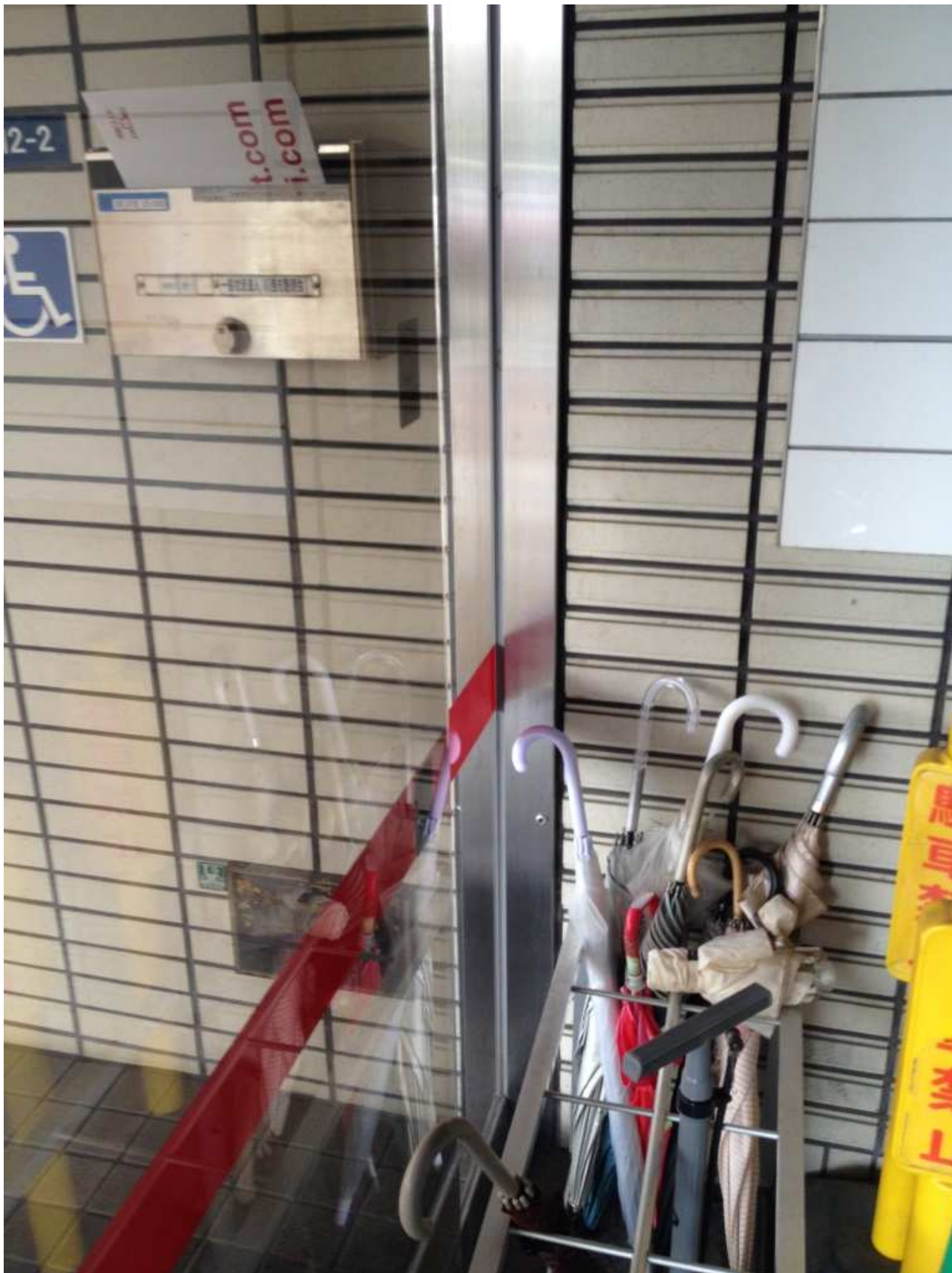
↓風除室 外側自動ドア補助光線取付の様子
