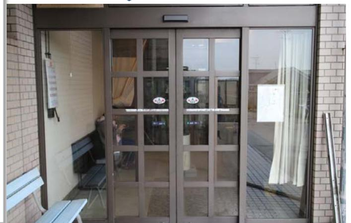
今はもう生産されていない油圧モーター式の自動ドア装置から、最新式の自動ドア開閉装置へ変更されました。
