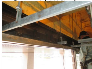
⑥ 施工中(補助光線)
