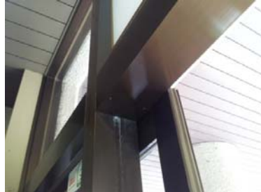
⑤ 施工中(新規枠ドア鎌錠)
