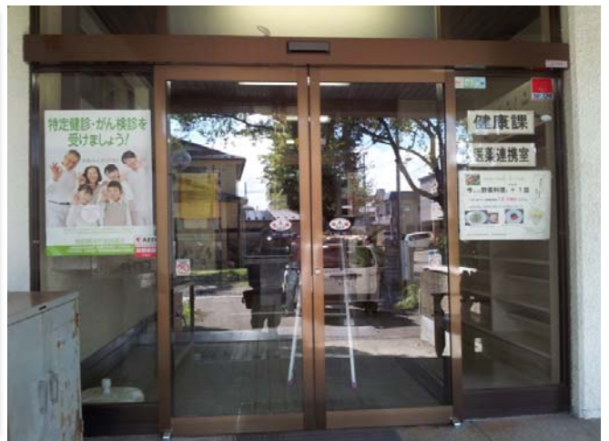
⑧ 施工完了(自動ドア化完了)
