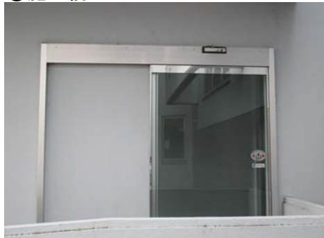
② スロープの様子
