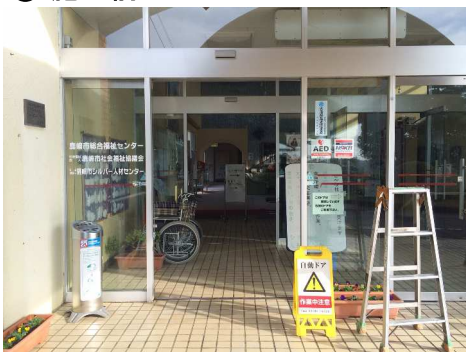
② 施工中(老朽化装置)
