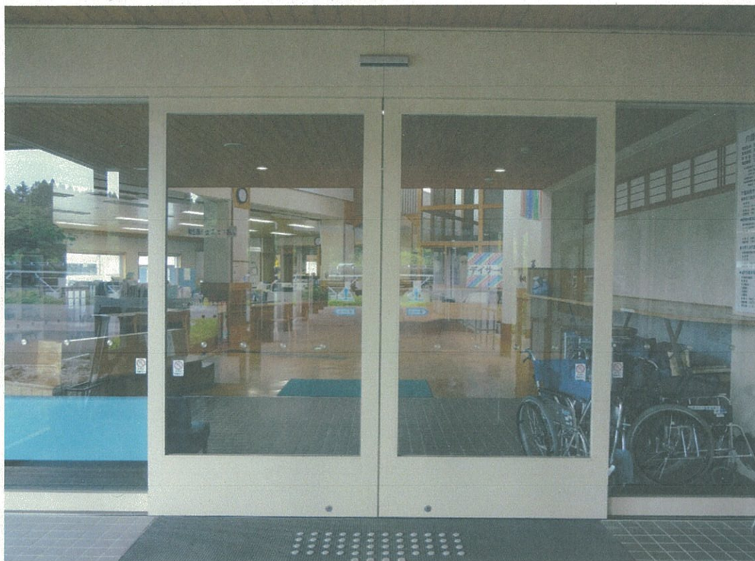
白河市表郷デイサービスセンター(福島県白河市) 正面玄関 自動ドア(風除室から内側ドアを撮影)
