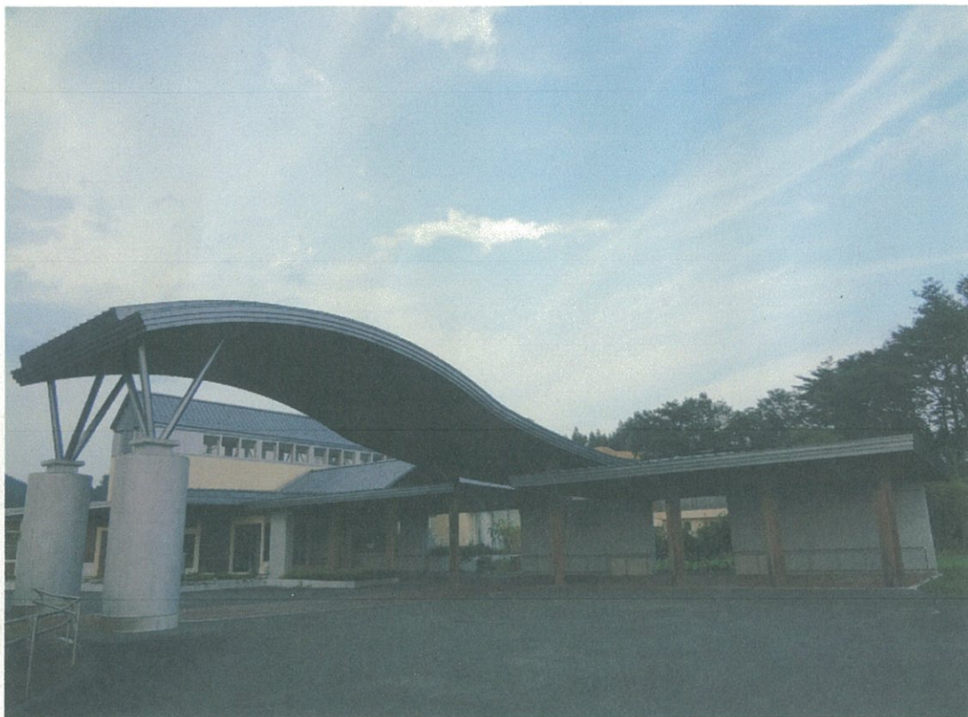
白河市表郷デイサービスセンター(福島県白河市) 正面より全景
