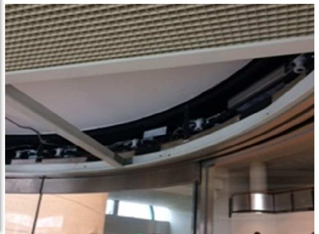
天井裏にある円形自動ドア装置を新規装置へと入れ替えました。同時にセンサー類も新しいものに取り替えて、安全性も高まりました。
