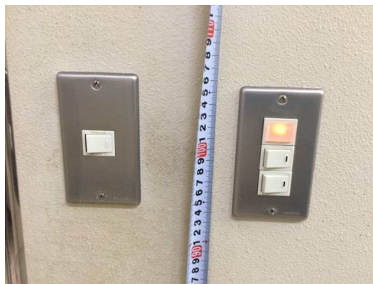
トイレ内電灯他スイッチの様子
