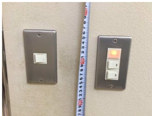
トイレ内電灯他スイッチの様子
