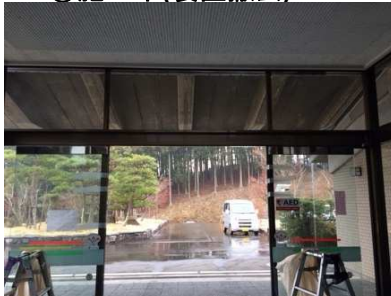
⑥施工中(新規装置)
