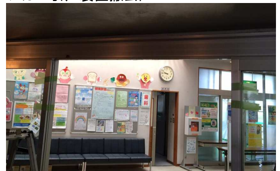
⑤ 施工中(上:自動ドア装置 下:ハンガー引戸)
