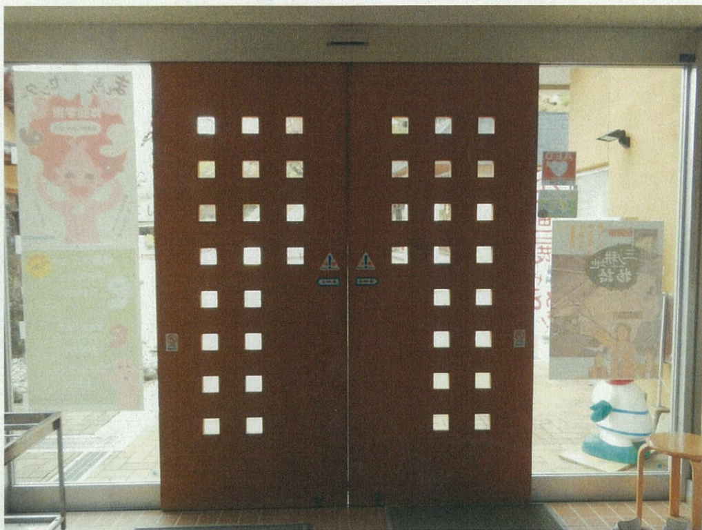
埋蔵文化財センター正面玄関：外側自動ドアの内側
