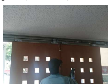
⑥ 自動ドア装置交換完了
