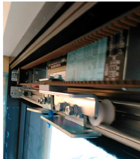
⑤ 施工中(新規自動ドア装置)
