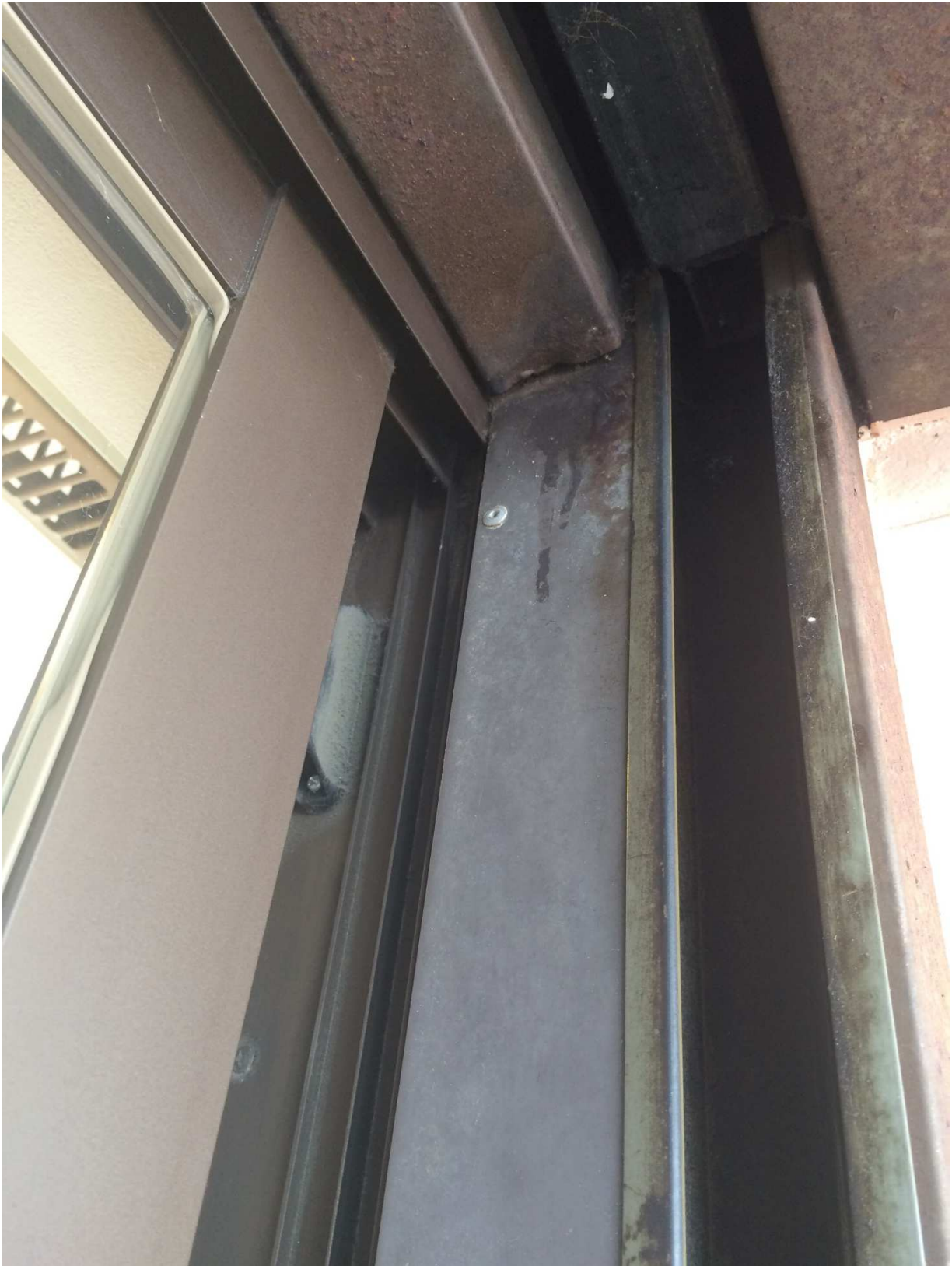
シャッターの様子
