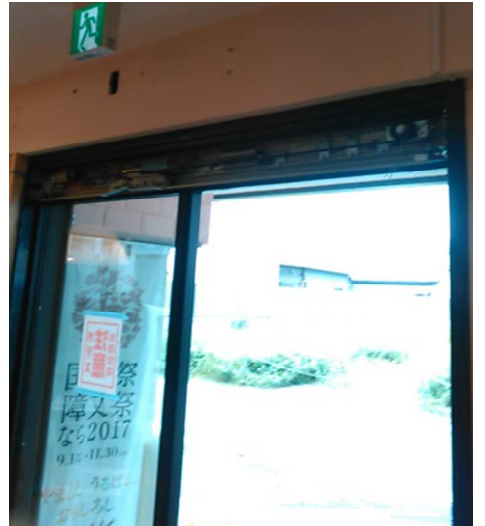
⑥ 施工中(新規自動ドア装置)
