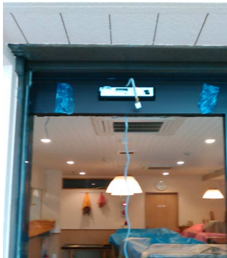
③ 施工中(センサ)
