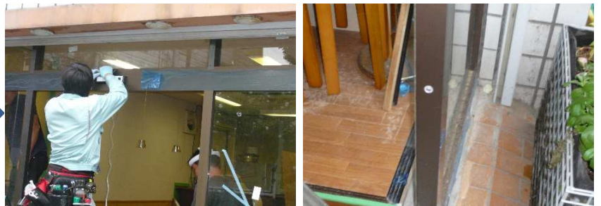
⑤ 施工中(ドア吊り込み、タッチスイッチ取付)
