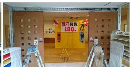
自動ドア開閉装置と内外センサ、補助センサ(光電センサ)一式を交換しました。
